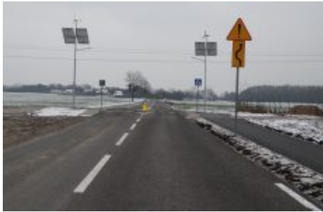
przebudowa - drogi - c5
